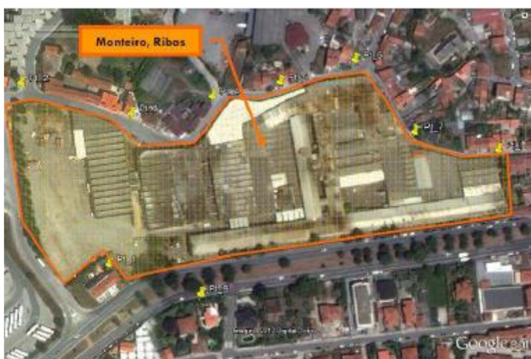
Figura- – Recetores sensíveis existentes na envolvente da MEEF (Pontos 1 a 9)
